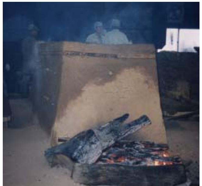
炉が完成した後、伝承した薪による乾燥手法を駆使し、炉の内側、外側を強制的に行う。
